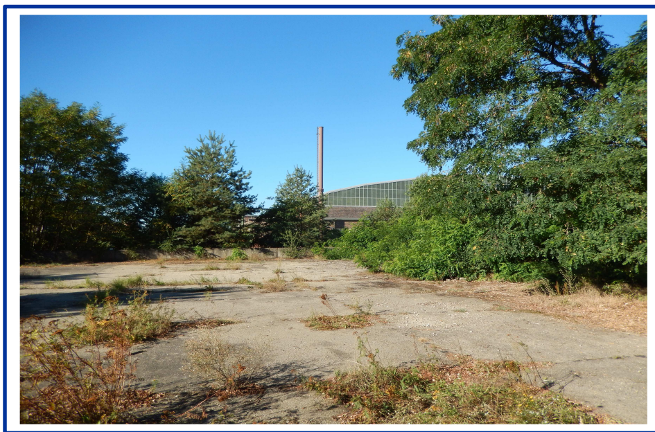
Gewerbegebiet Flugplatz Lönnewitz, Baufeld IV (Quelle: BBG)
