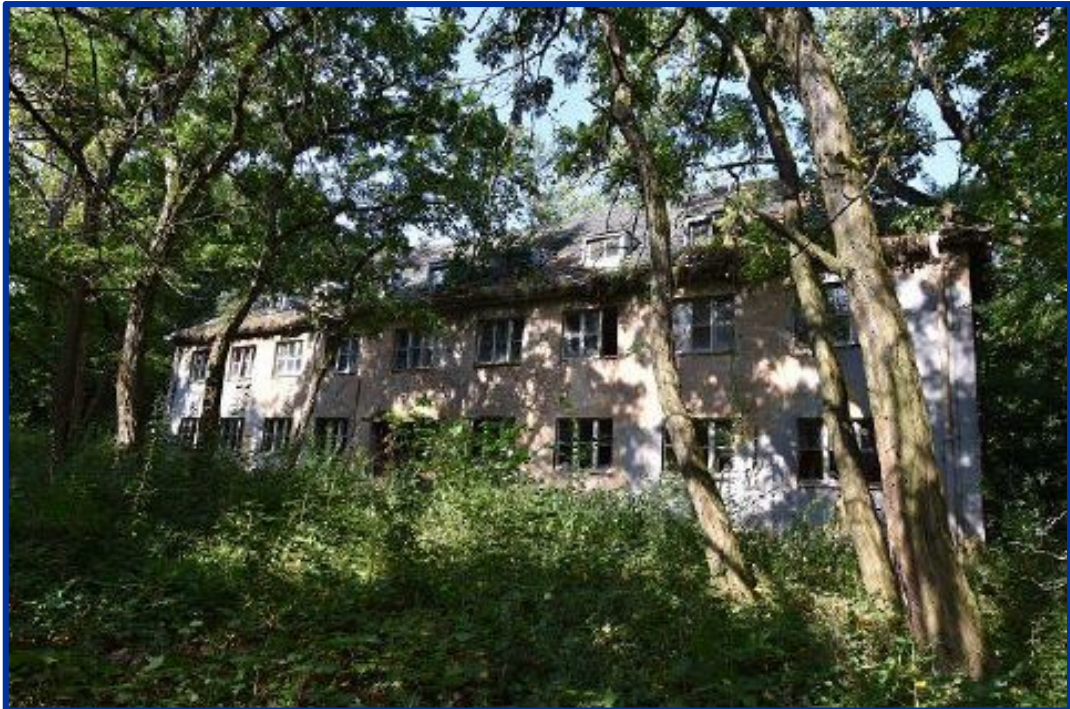
Blick auf ein Unterakunftsgebäude Baujahr 1935 (Quelle: BBG)
