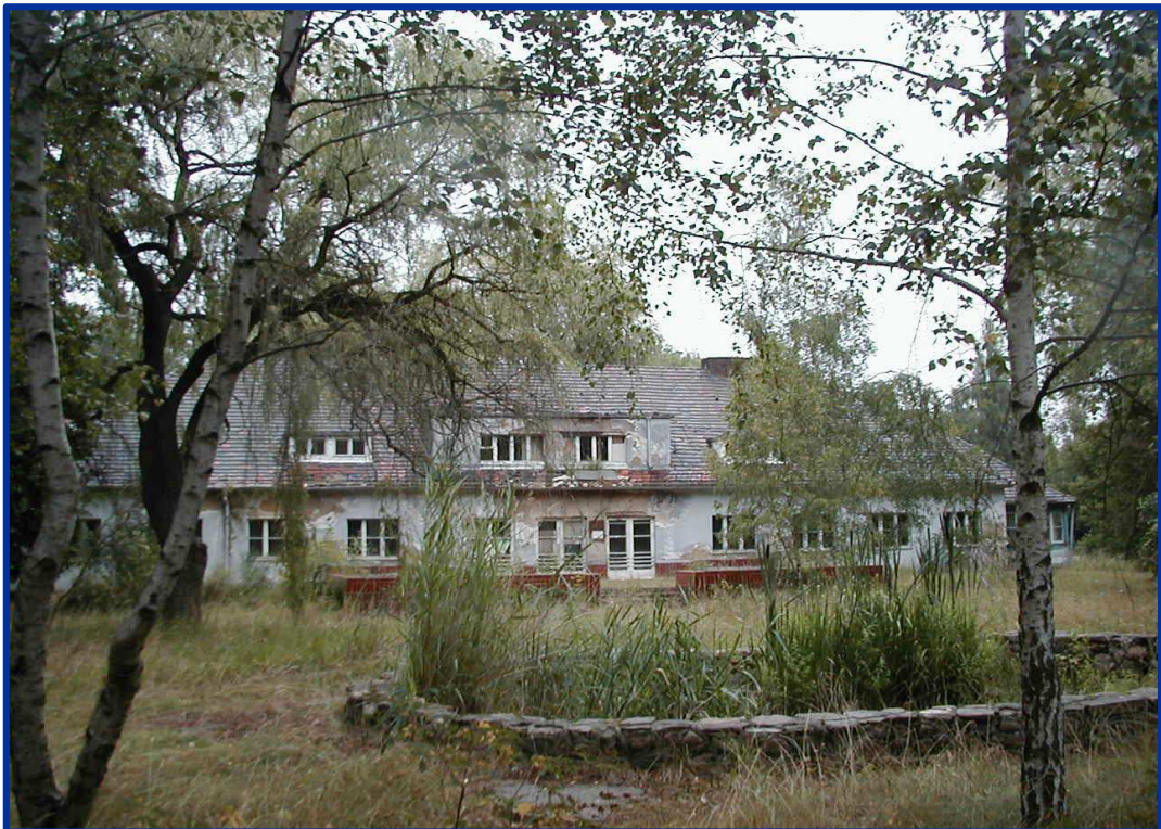
Blick auf das Offizierskasino Baujahr 1935 (Quelle: BBG)
