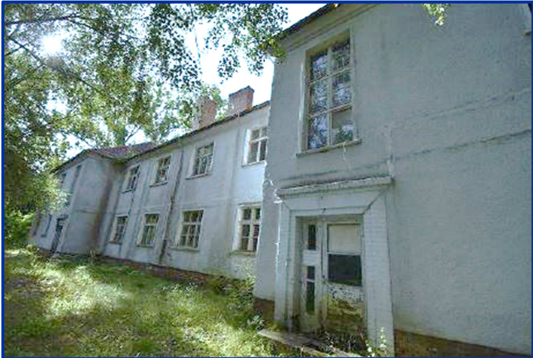
Blick auf ein Wohnhaus Baujahr 1935 (Quelle: BBG)
