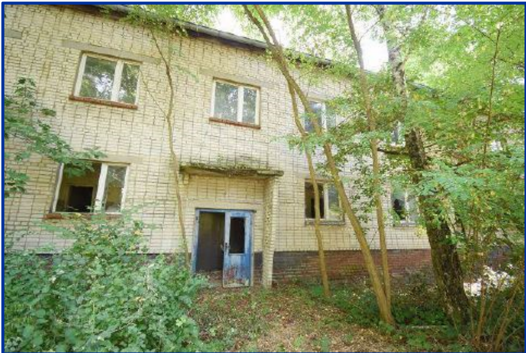
Blick auf ein Wohnhaus Baujahr 1976 (Quelle: BBG)
