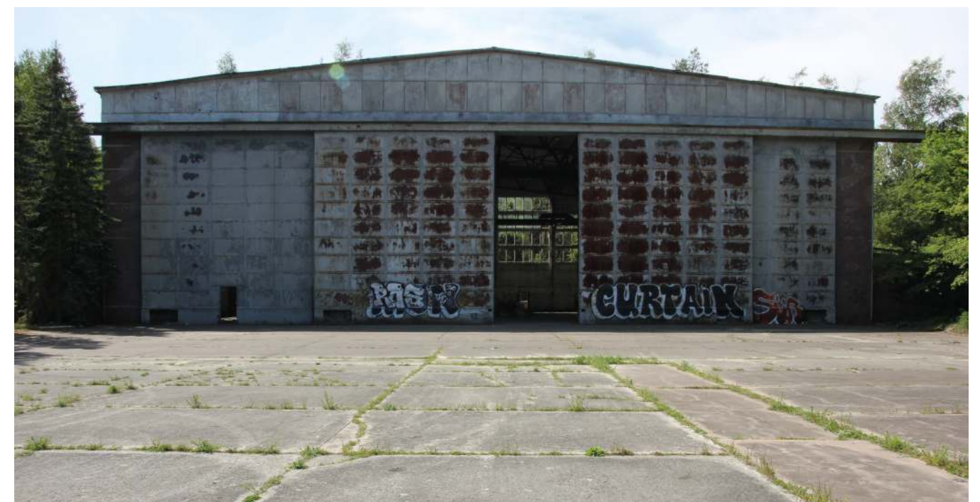
Abb. 32: Flugzeughalle (Hangar), Flugplatz Sperenberg (Foto, Andreas Kern, 2025)
