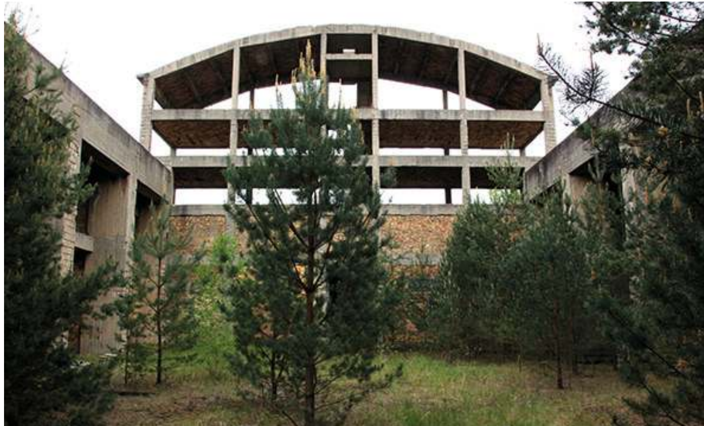
Abb. 25: Nicht fertig gestellter Bau der Montagehalle für den Mauspanzer, erbaut bis 1945 (Foto, hochC, 2014)
