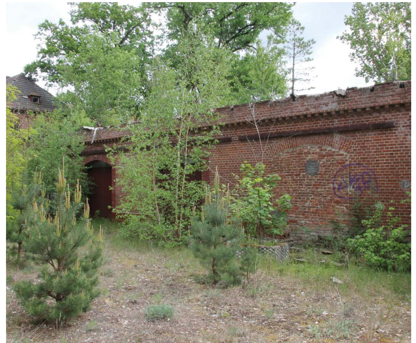
Abb. 70: Wagenhalle im Kasernengelände Kummersdorf-Gut (Foto, Andreas Kern, 2025)
