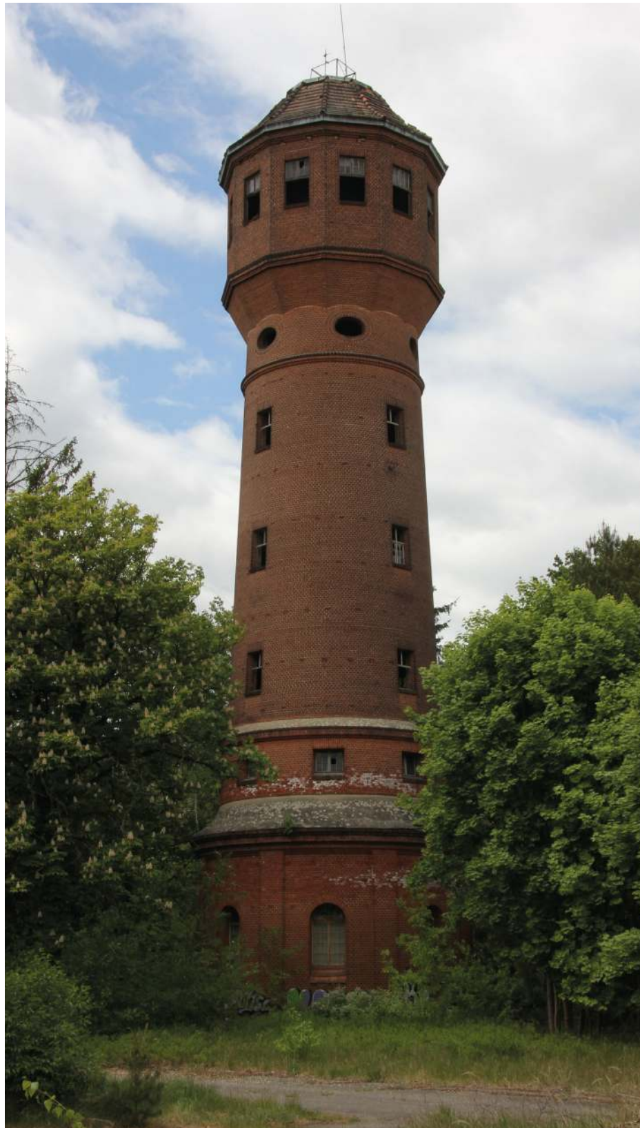
Abb. 69: Wasserturm in Kummersdorf-Gut (Foto, Andreas Kern, 2025)
