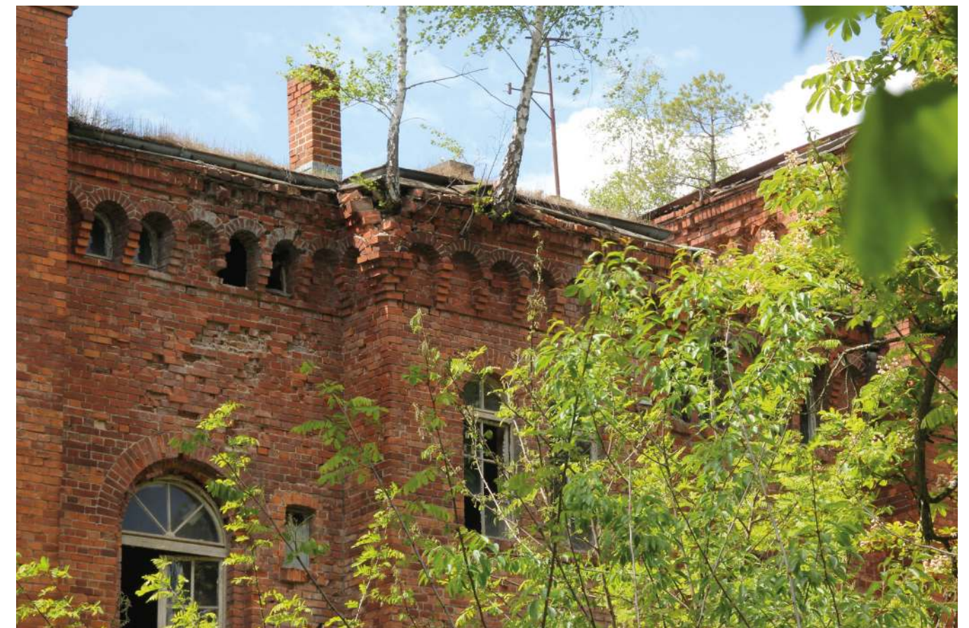
Abb. 29: Offizierskasino in Kummersdorf-Gut (Foto, Andreas Kern, 2025)
