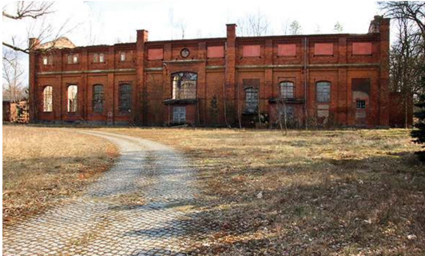
Abb. 20: Ansicht des Zeughauses von Nordwesten erbaut 1890 (Foto, hochC, 2014)
