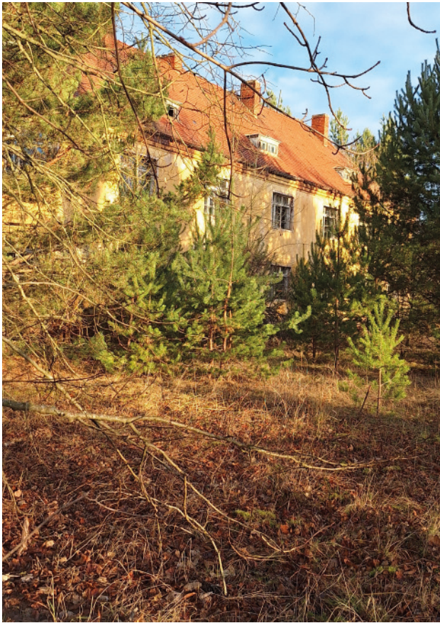
Anhang 26:Gebäudebestand, Foto: Gemeinde Am Mellensee
