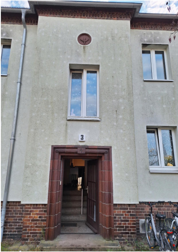
Anhang 28:Gebäudebestand, Foto: Gemeinde Am Mellensee
