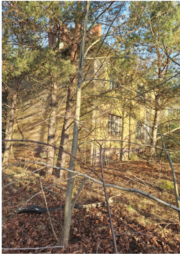
Anhang 25:Gebäudebestand, Foto: Gemeinde Am Mellensee
