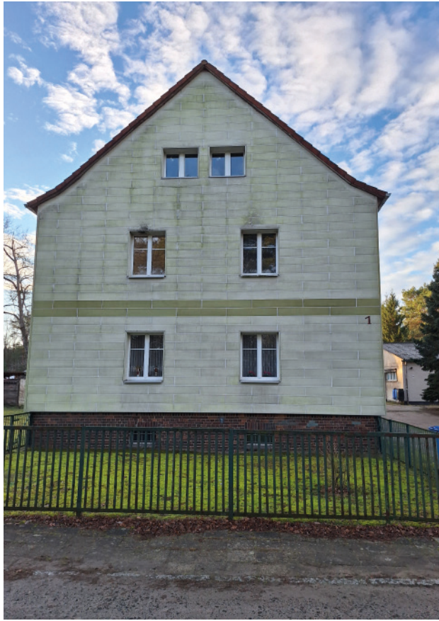
Anhang 27:Gebäudebestand, Foto: Gemeinde Am Mellensee
