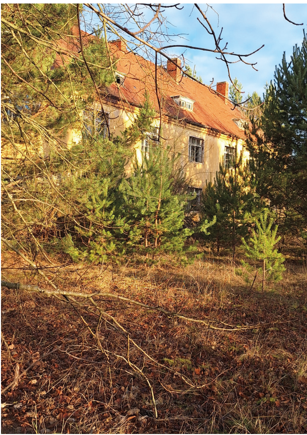
Anhang 30:Gebäudebestand, Foto: Gemeinde Am Mellensee
